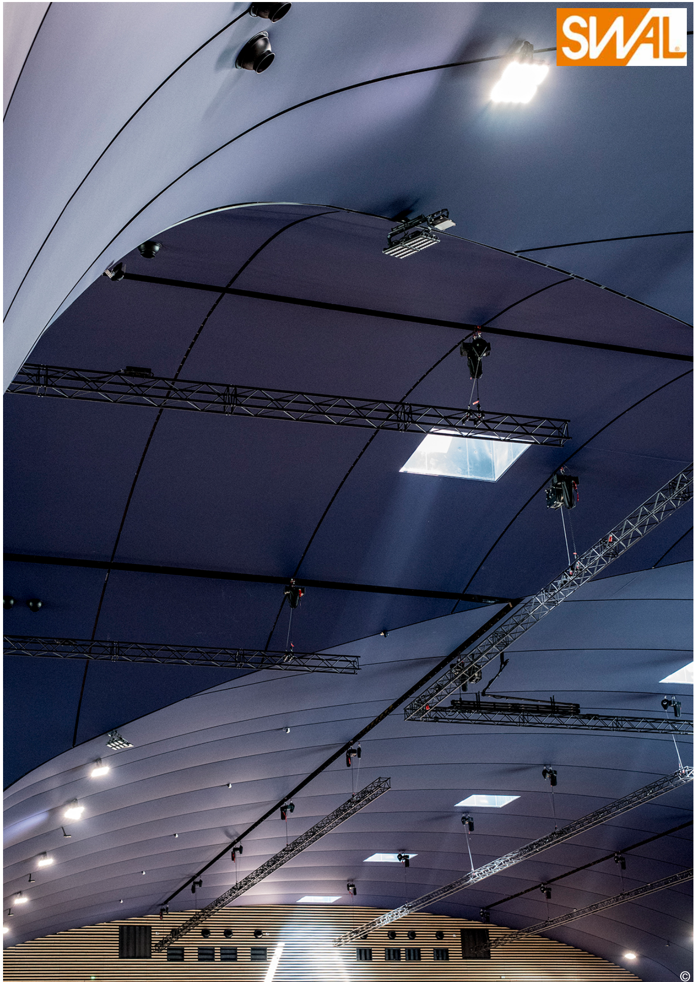
Conception et mise en oeuvre en 3D volume de 15 000m 2 de toile acoustique SWALtex bleu-caban sur la totalité des voûtes des galeries ainsi que dans la grande noue centrale, haute performance. Alphasabine = 1 /. Structure porteuse déportée semi-rigide/plenum de 500mm et complexe absorbant multicouches.
